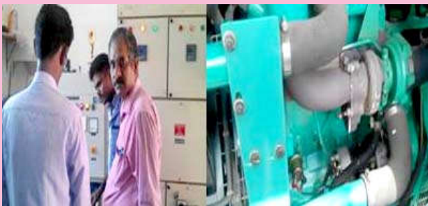
M/s AVN Hospital, Vilacherry, Madurai
