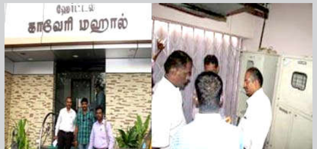
M/s Kaveri Mahal, Madurai.
