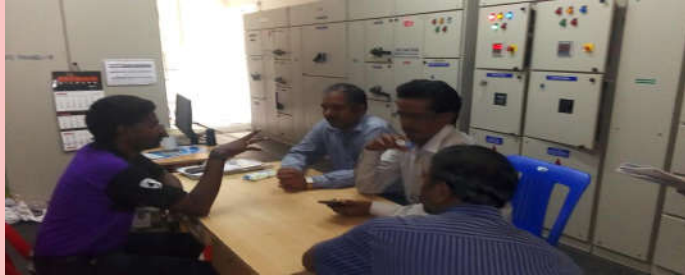
Energy Audit at M/s.VETRI CINIMAS Madurai
